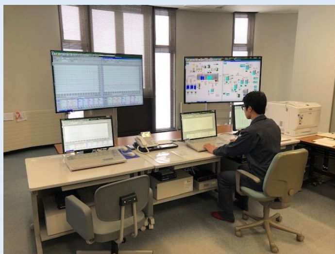
浄水場での運転管理業務の様子
