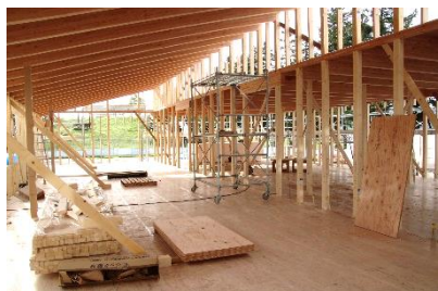
増築校舎の様子(9/28)
