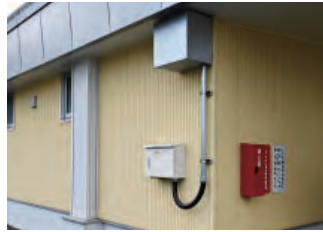
災害時に外部電力を接続する設備(富小体育館)
