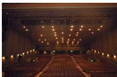
取替え困難な天井の照明
