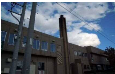
アスベスト含有のボイラー煙突
