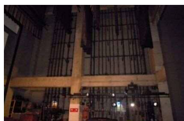
老朽化した舞台設備
