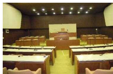
議場 天井に吹付アスベスト使用
