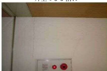
内壁のひび割れ
