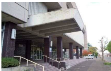
玄関入口の段差 庇の剥離
