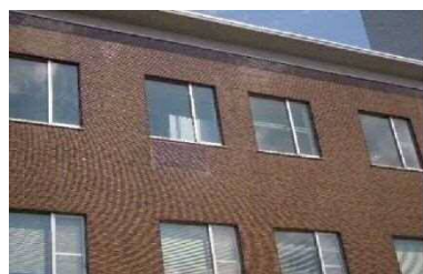
外壁落下による補修跡
