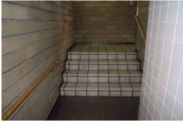
大ホールトイレ入口の段差
