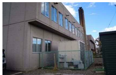
水冷式冷房設備
