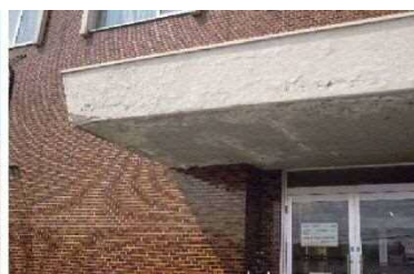
出入口の庇の剥離
