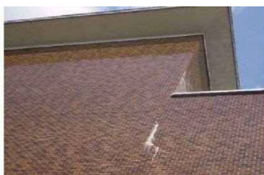
外壁のひび割れ
