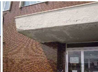
出入口の庇の剥離
