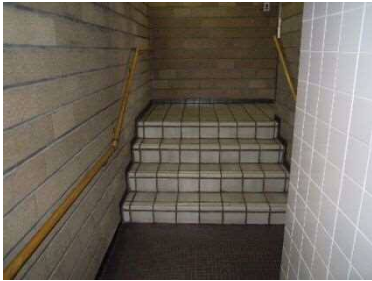
大ホールトイレ入口の段差
