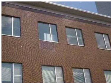
外壁落下による補修跡
