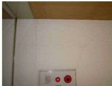
内壁のひび割れ
