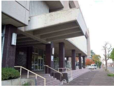
玄関入口の段差 庇の剥離
