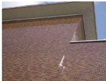
外壁のひび割れ
