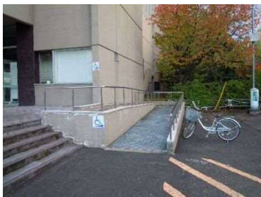
車いす用スロープ
