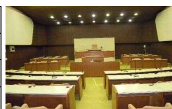
議場 天井に吹付アスベスト使用
