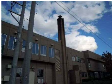
アスベスト含有のボイラー煙突
