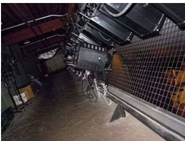
天井裏のキャットウォーク
