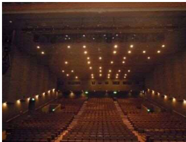
取替え困難な天井の照明
