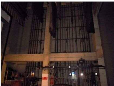
老朽化した舞台設備
