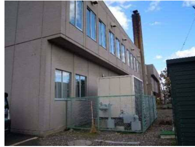
水冷式冷房設備
