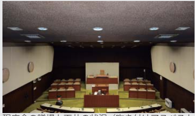
現庁舎の議場と天井の状況（吹き付けアスベストは天井の裏側で囲い込み経過観察）
