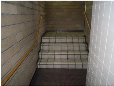
大ホールトイレ入口の段差
