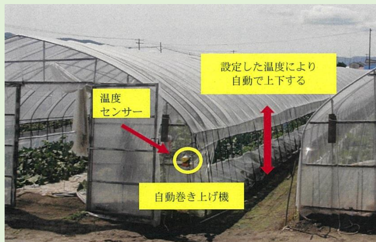
ハウス自動換気設備
