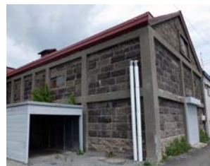
▲旧本間農場倉庫（日の出町所在。外壁補強は昭和32年施工）
