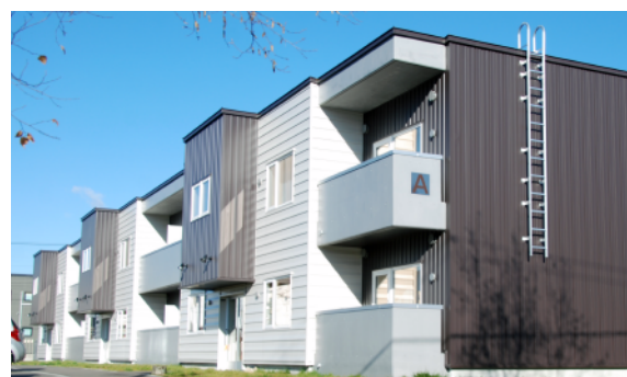
旧麻町保育所跡地に建設された公営住宅(西麻町)
