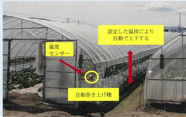
ハウス自動換気設備
