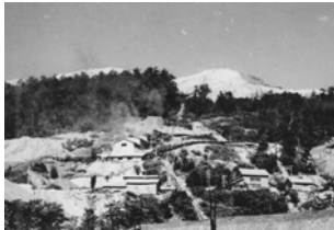
▼山部石綿鉱山（昭和39年）
