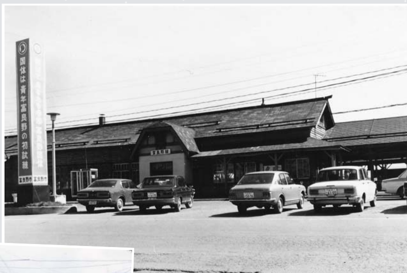
▲旧富良野駅（左端は国体広告塔）
