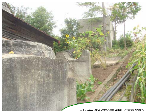
水力発電遺構(麓郷)
