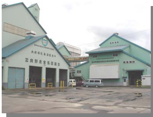
JA 乾燥調整施設
