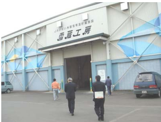
玄米貯蔵施設（雪蔵工房）
