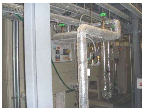
ヒートポンプ 施設
