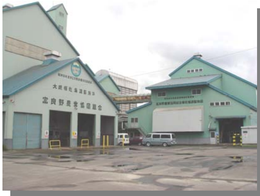
JA 乾燥調整施設
