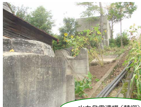
水力発電遺構（麓郷）
