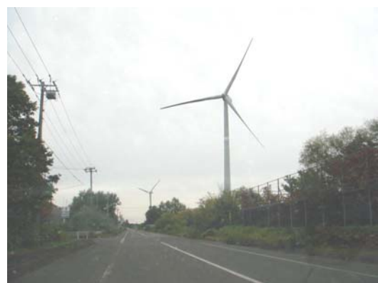
風力施設外観
