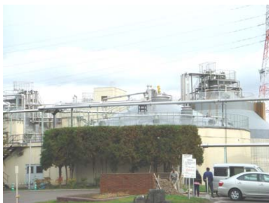
消化ガス製造タンク
