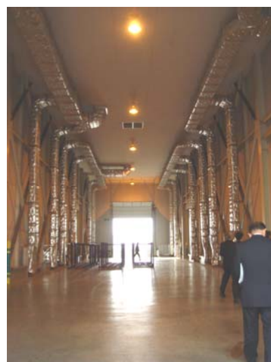
施設内（パイプ配管状況）
