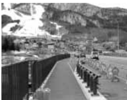
3月26日に供用を開始した国道38号新空知橋の改良工事
