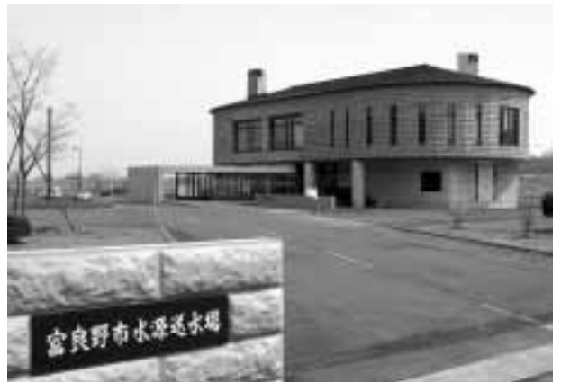
上下水道課が移転する中五区水源送水場
