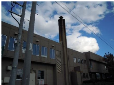
アスベスト含有のボイラー煙突
