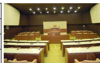
議場 天井に吹付けアスベスト使用
