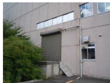
隣地があり車両の横づけができない搬入口
