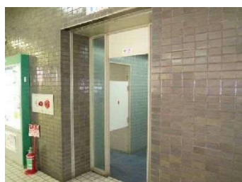
狭く開閉式扉のトイレ
