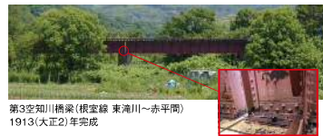
第3空知川橋梁(根室線 東滝川～赤平間) 1913(大正2)年完成
