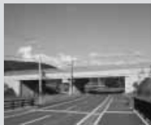
旭川十勝道路の着工
