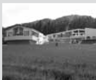
ハイランドふらの浴室棟増築
