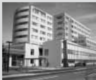
地域センター病院改築への助成
