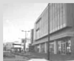
中心街活性化センターの建設
