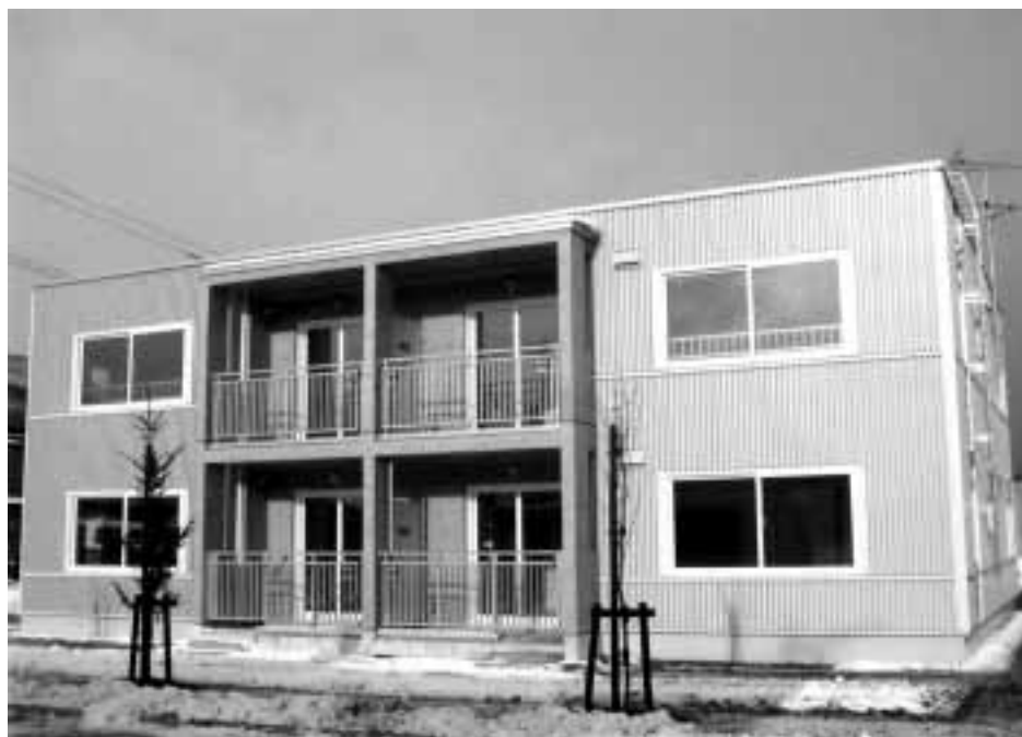
▲平成16年度発注の公営住宅（北の峰G棟）
