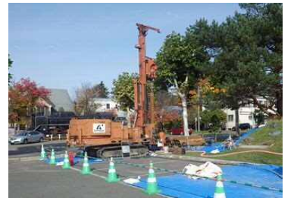
庁舎前庭での掘削状況
