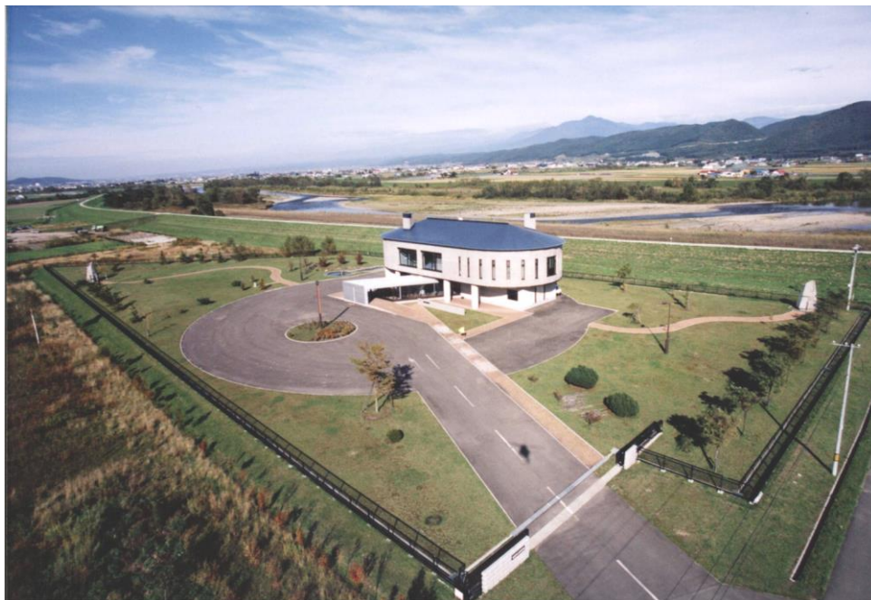
中五区水源送水場
