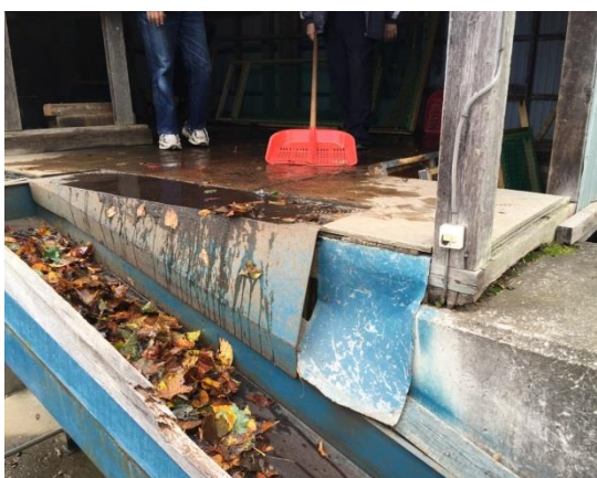
除塵スクリーンから 枯葉を手作業で掃除をする様子
