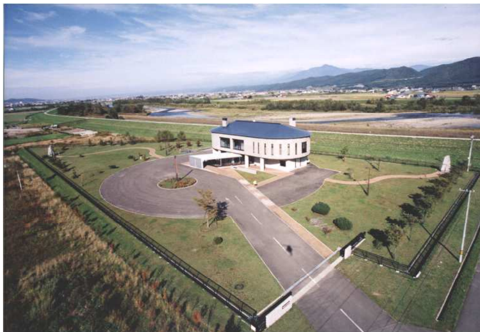
中五区水源送水場
