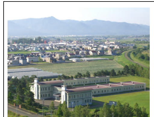
富良野水処理センター
