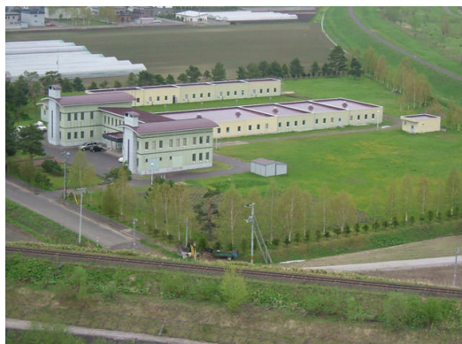
富良野水処理センター
