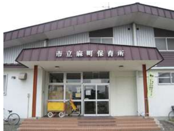
昭和 47 年に建設された麻町保育所
