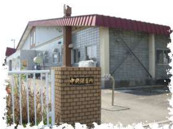
昭和 51 年に建設された中央保育所
